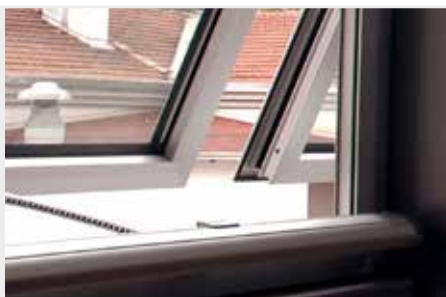
Алюминиевый корпус электропривода обрезается по ширине створки
